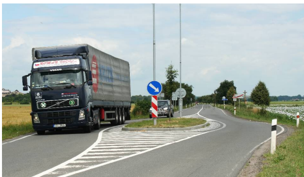
Obrázek 2 – Zvýraznění změny funkce pozemní komunikace pomocí oboustranně vychýleného ostrůvku na vjezdu do obce - příklad fyzického zklidnění, které bývá často považováno za samovysvětlující utváření
