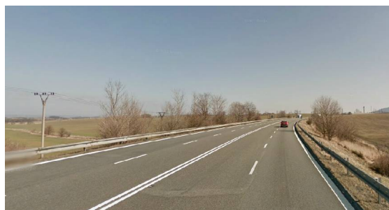
Obrázek 14 – vhodný kandidát na změnu uspořádání? Silnice I/48 u Nového Jičína
